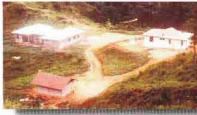
Construcción de infraestructura en el CADETH. Construction of the infrastructure at CADETH.
