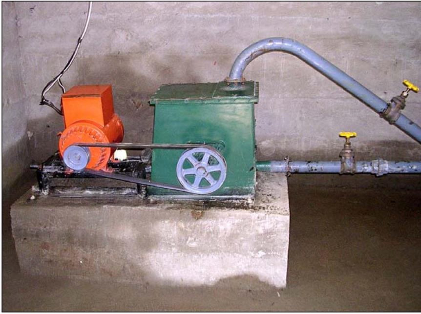
**Microhidroturbina de dos boquillas con generador de 7.5 kW.**
