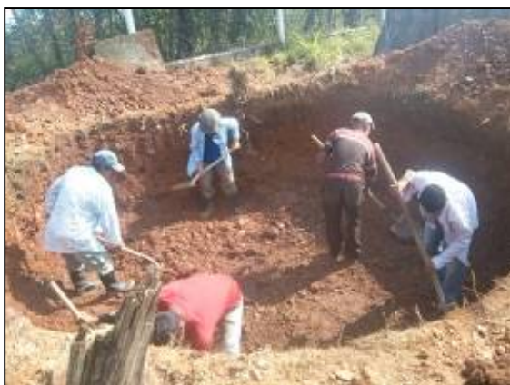
Figura 13. Apertura de agujero para instalar tanque.
