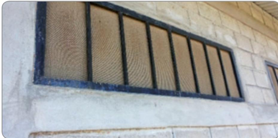
**Figura 6.** Ejemplo de ventanas con malla para evitar entrada de insectos y otras plagas.
