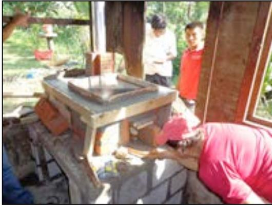
Al finalizar la construcción de la estufa, se procede a realizar una prueba de encendido rápido. Esto con para que los participantes conozcan el funcionamiento, uso y mantenimiento de la estufa.
