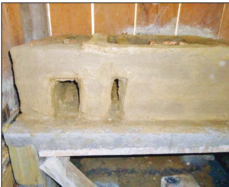
Vista lateral de la estufa y los boquetes de 5" y 2.5".
