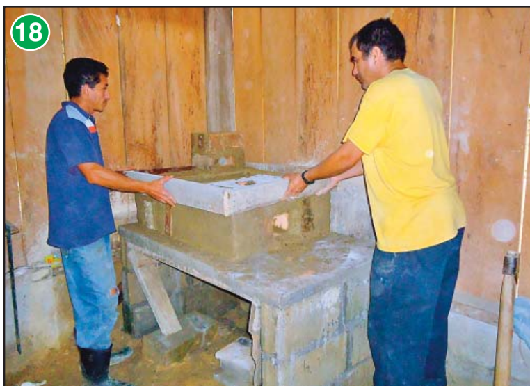
Colocar el marco de madera para nivelar y rellenar con mezcla la parte superior de la estufa.
