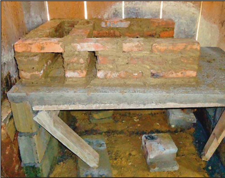
Vista lateral de la estufa con 3 hiladas y los boquetes de 5" y 2.5" formados.
