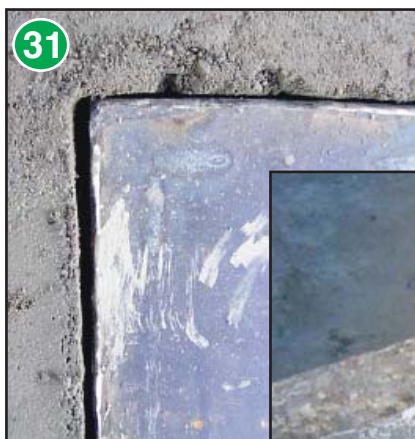
Rellenar con ceniza la ranura en el borde de la plancha para evitar la salida de humo,
