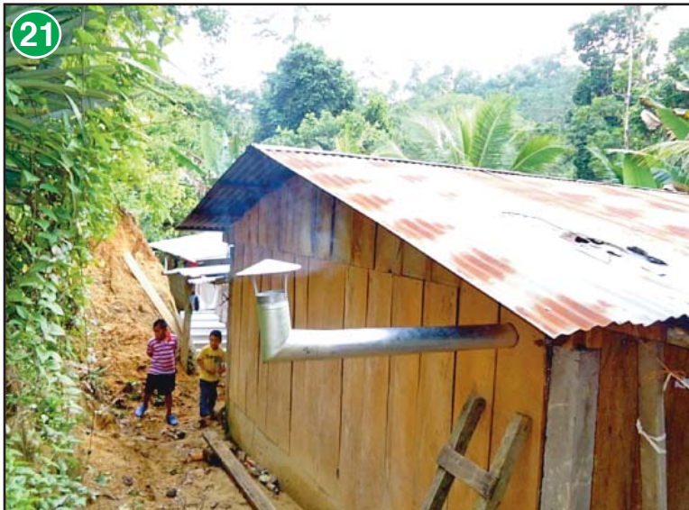
Colocar el tubo y el segundo codo en la parte externa de la vivienda.
