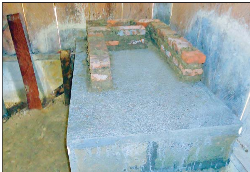
Vista frontal de la estufa construida con 2 hiladas de ladrillos.
