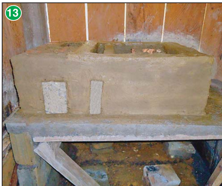
Tapar los boquetes. Se puede utilizar ladrillo o madera.
