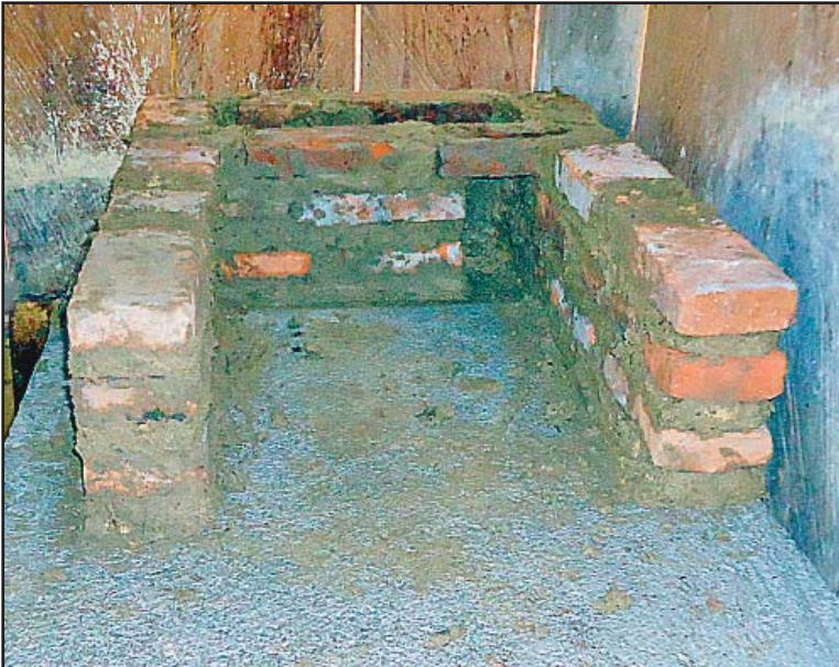
Vista frontal de la estufa con 3 hiladas y 4 paredes construidas.
