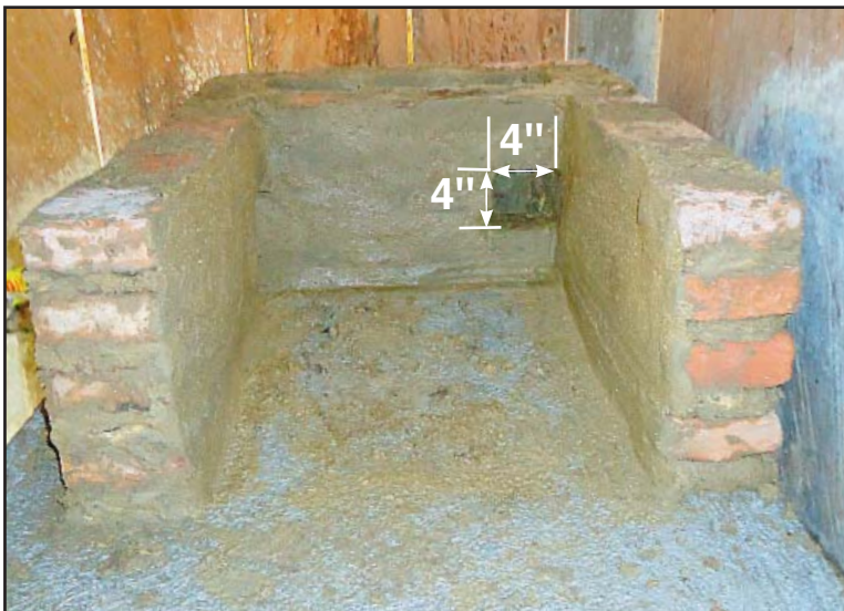
Vista frontal de la estufa con la cuarta hilada terminada y el boquete de 4" x 4" formado. Se pueden revocar las paredes internas de la estufa.
