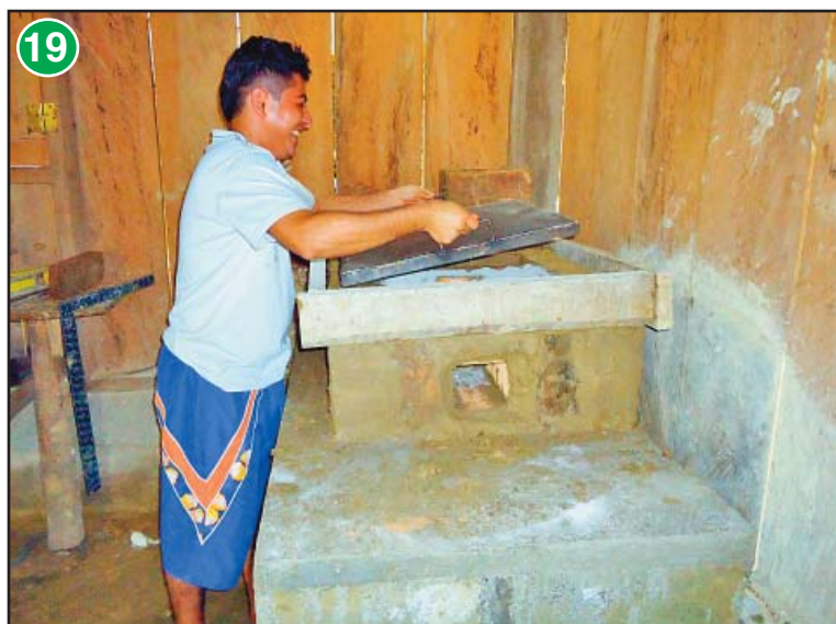
Colocar la plancha. Se debe verificar que la plancha quede bien ubicada con respecto a las paredes de la estufa.
