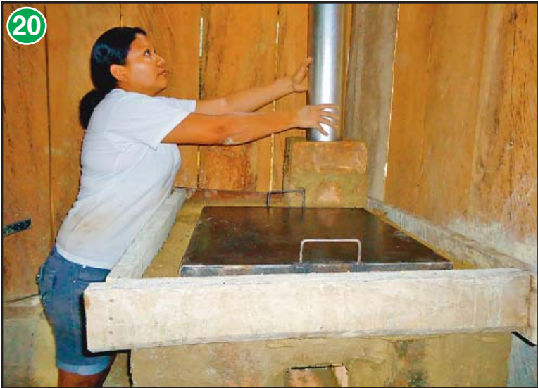
Colocar el tubo de la chimenea y el codo en la parte interna de la vivienda.
