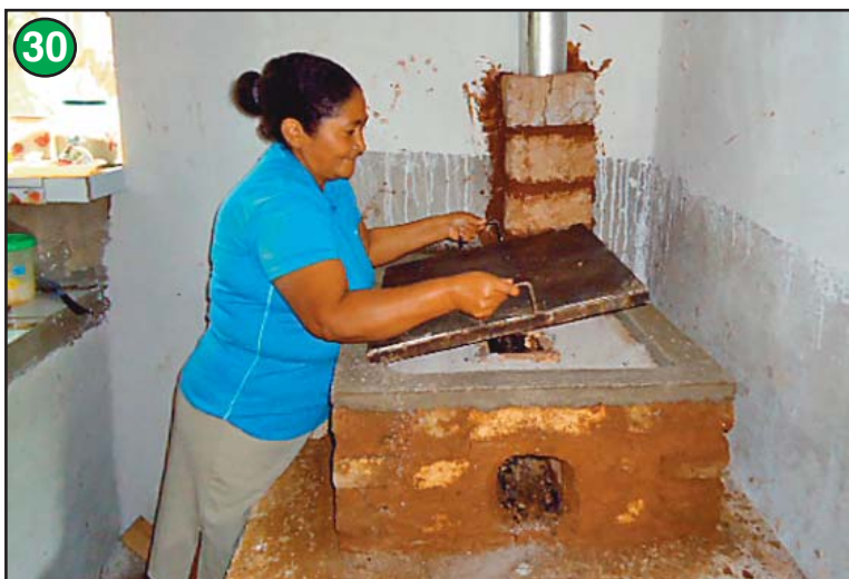
Colocar la plancha.
