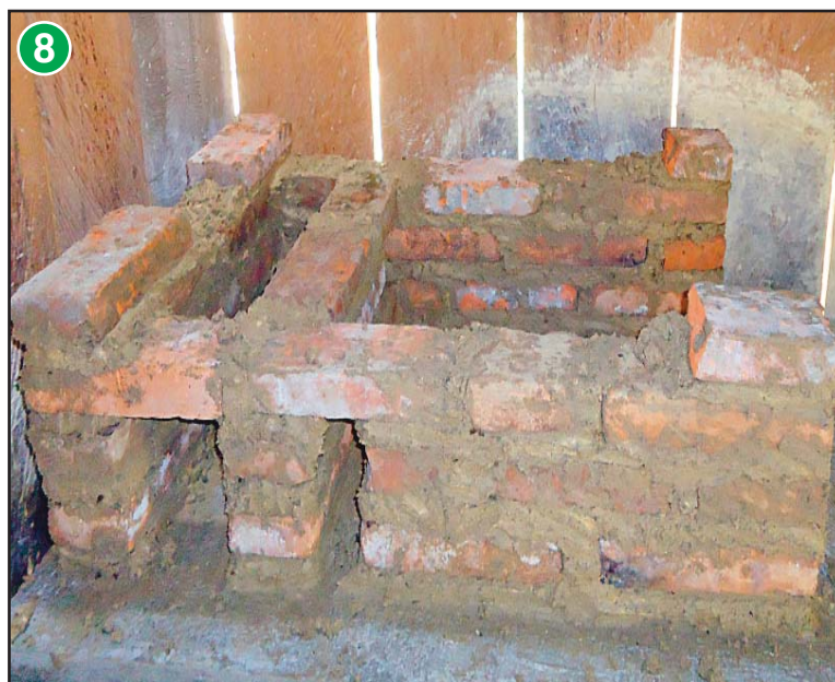
Colocar los 4 ladrillos (uno en cada esquina) para construir la cuarta hilada.
