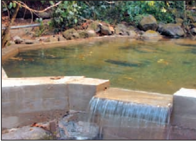
Figura 4. Para asegurar el abastecimiento de agua sobre la tubería de presión se acostumbra erigir una pequeña presa de mampostería.
