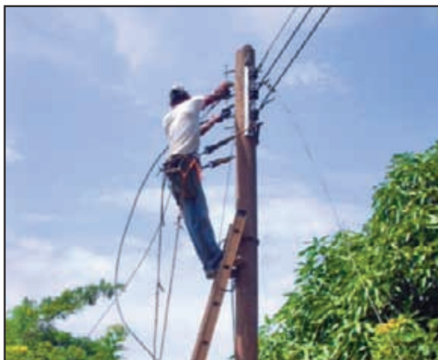
Figura 11. La red de distribución debe ser instalada por personal técnico capacitado.
