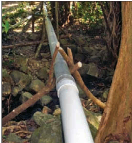
Figura 8. Para obtener una caída vertical apropiada, la tubería de presión generalmente se instala con dificultad siguiendo pendientes muy pronunciadas.
