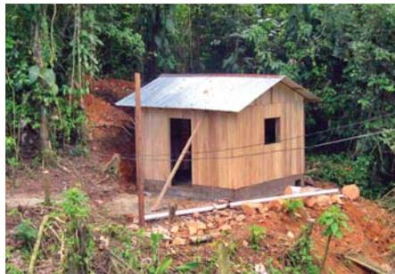
**4** Construcción de casa de máquina para instalar la microhidroturbina.
