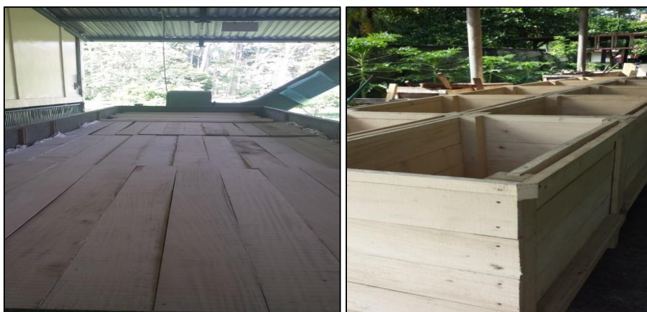
Figura 10. Secado de madera y construcción de cajones en el CEDEC-JAS.
