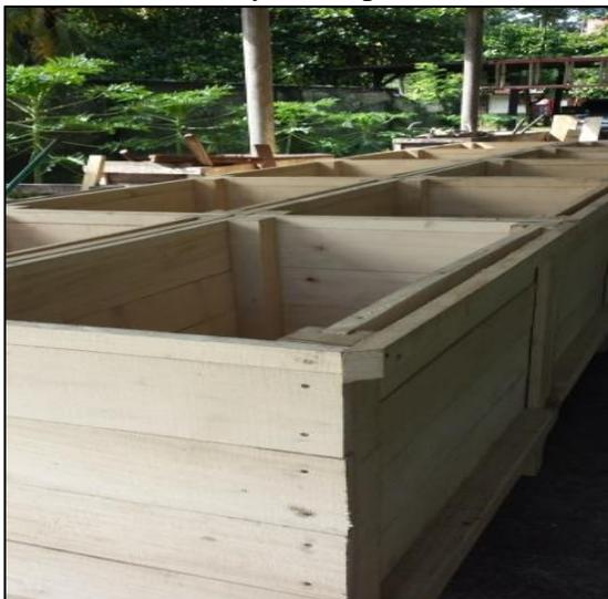
Figura 9. Construcción de cajones para fermentación de cacao en CEDEC-JAS para Proyecto Merendón.
