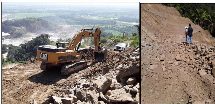
Figura 15. Máquina removiendo broza (izquierda) y broza lista para transformación (derecha).
