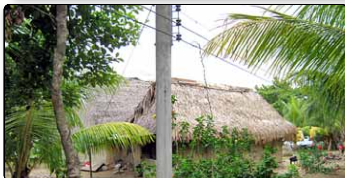
Microhidroturbina que genera la electricidad en la comunidad de Plan Grande, Santa Fe, Colón.
