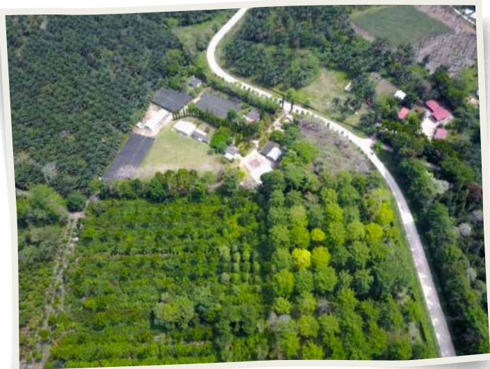
Vista parcial del CEDEC-JAS.
