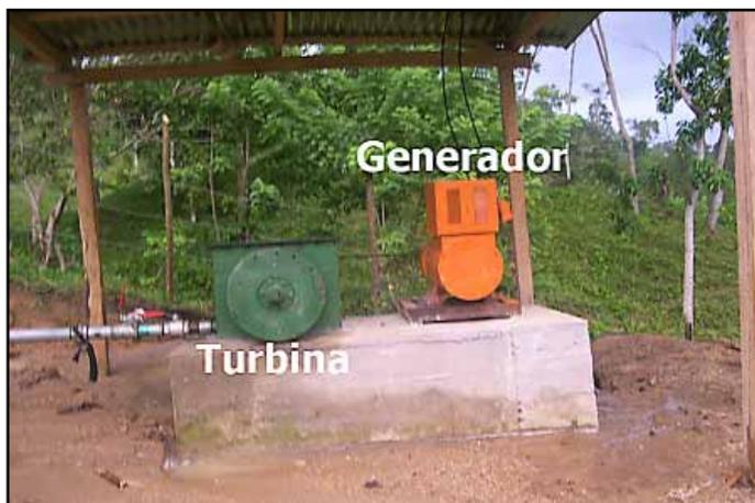
Microturbina y generador de energía eléctrica instalado en la comunidad de Las Delicias, Esparta, Atlántida.
