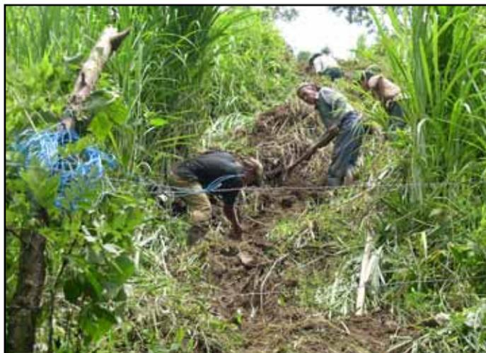
Los miembros de la comunidad participaron en la apertura de la zanja donde se instaló la tubería que conduce el agua hacia la microturbina.
