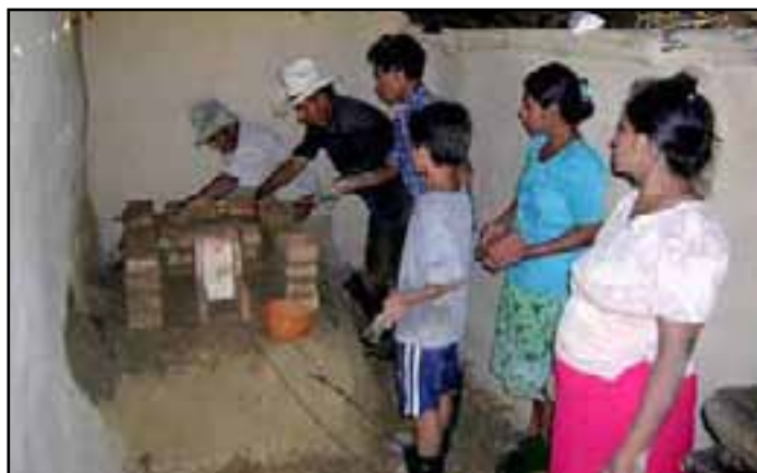
Hombres y mujeres participan activamente en la construcción de la estufa en Satalito, Balfate, Colón.
