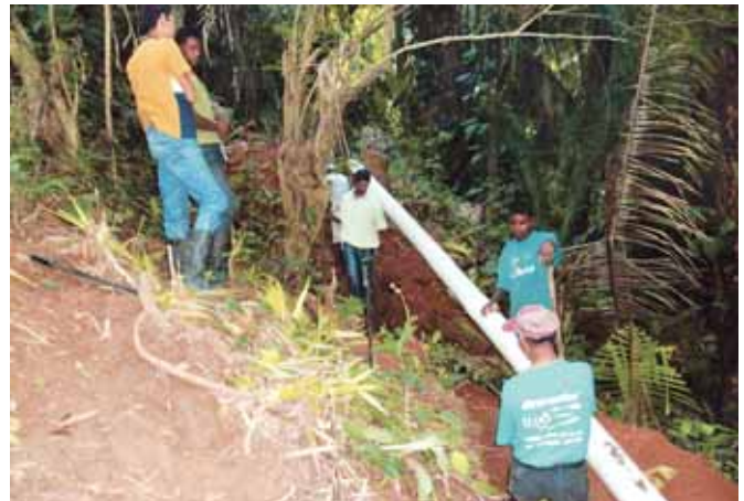
La comunidad participa activamente en todo el proceso de instalación de la microhidroturbina.
