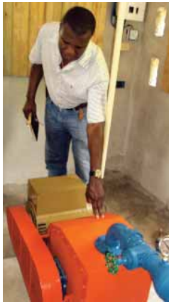
El agua es conducida por tubería de PVC de alta presión, mueve la micro turbina y retorna al cauce natural del río.
