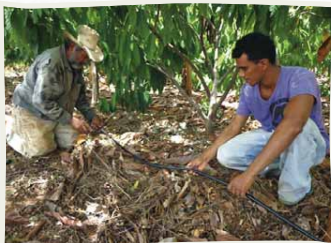
Sr. Nery Henríquez (izq.) participando en la instalación de su sistema de riego por goteo en su parcela de cacao.
