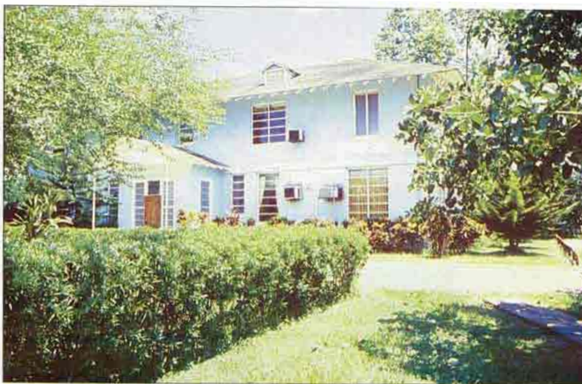
El Edificio de Administración de la FIIA antes de 1984.
