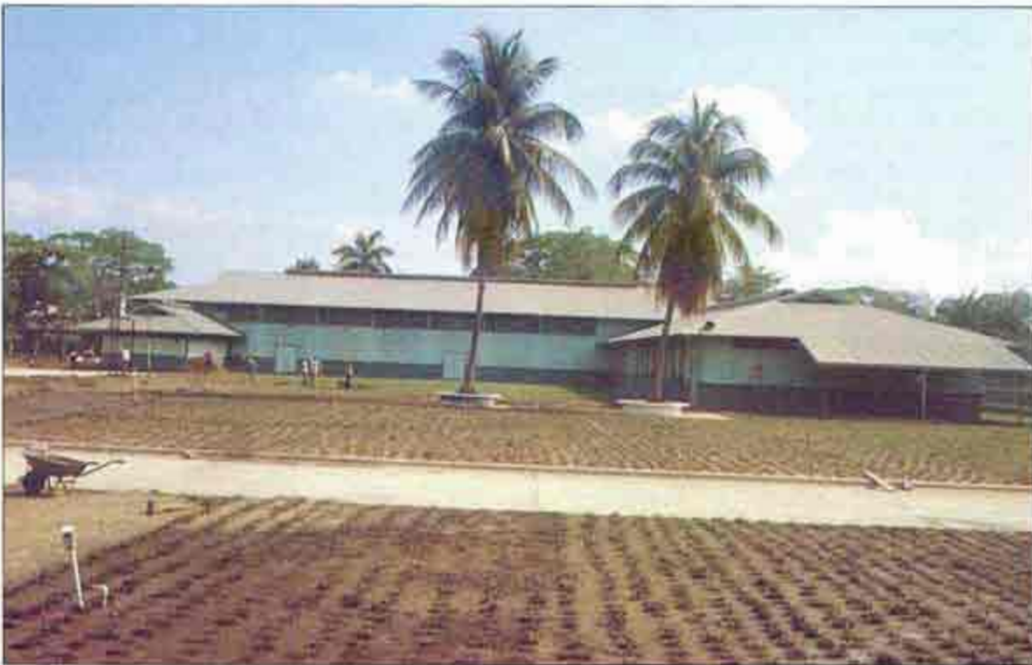
El antiguo Club Sula, una vez remodelado, albergará la División de Comunicación.
