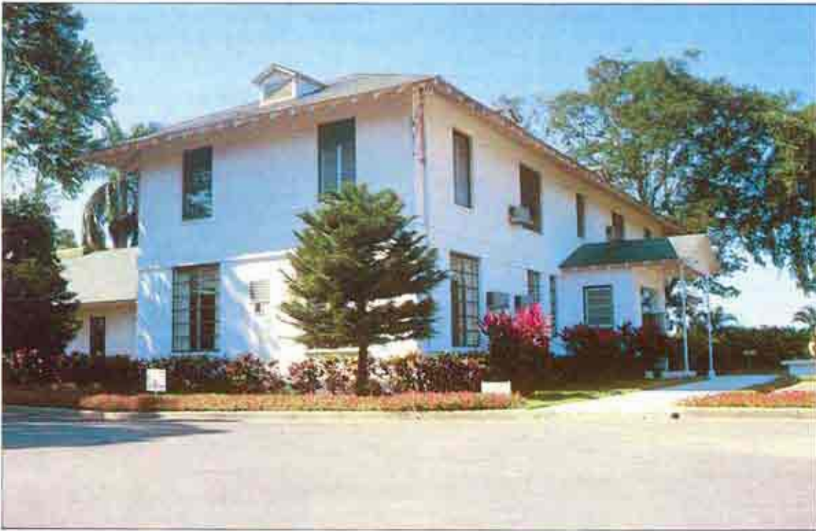
Vista actual del Edificio de Administración de la FIIA.
