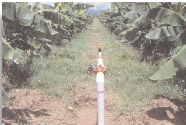
Foto 1. La instalación de aspersores de irrigación forma parte de los trabajos de rehabilitación en el CEDEG de la FHIA.
