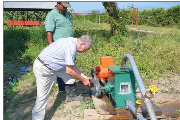
Centro de evaluación de micro hidro turbinas en la sede central de la FHIA en La Lima, Cortés, para detectar anomalías de construcción o diseño del sistema.
