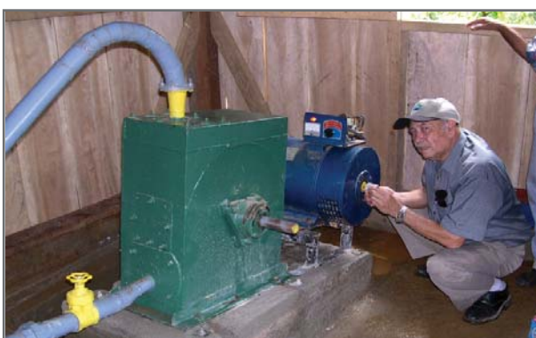
Mediciones y pruebas de ajuste en una MHT de dos boquillas en la comunidad de El Recreo, La Masica. Proyecto GTZ-FHIA. 2006.
