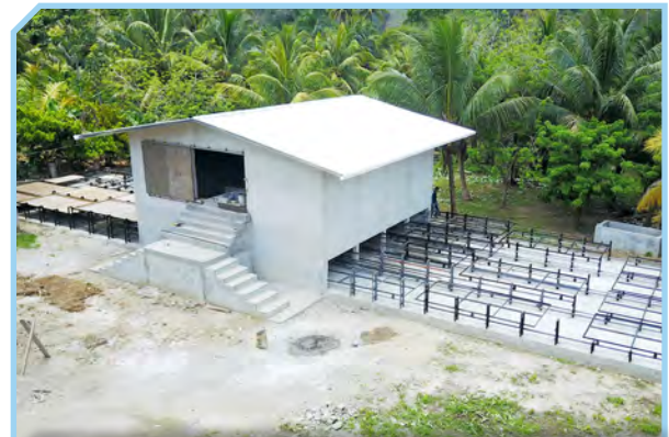
Construcción del centro de beneficiado de COPROCADER.
