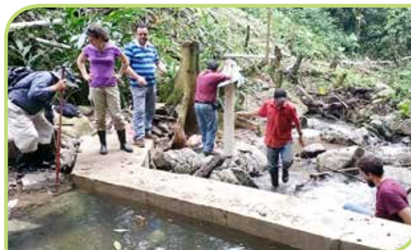
Personal de ETEA y miembros de la comunidad trabajando en la instalación del sistema hidroeléctrico.
